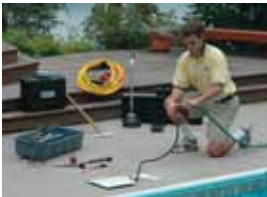
opsporen van lekkages
