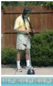
lekkage onder terras opsporen
